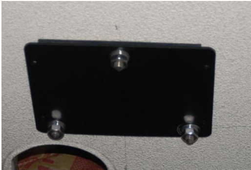
図 16 アダプタープレート本体を取り付けたところ
